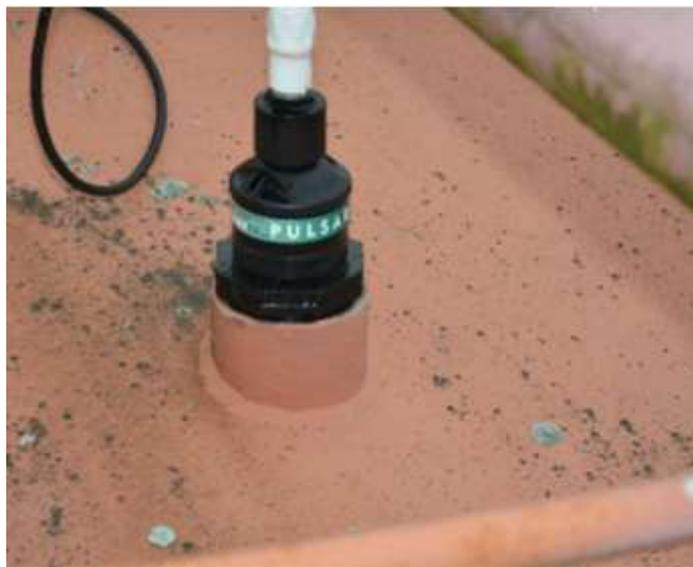
Серия dV Transducer - это серия датчиков уровня для сточных вод и промышленных сред. В диапазоне от 3 м (9,8 ф) до 50 м (164 фута) все наши ультразвуковые датчики уровня обеспечивают надежное измерение уровня, объема, расхода в открытом канале, управления насосом и дифференциального измерения уровня как для жидкостей, так и для твердых веществ.
