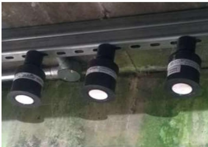
Мониторинг уровня сточных вод стал простым благодаря интеллектуальным датчикам уровня dBi HART. Преобразователи dBi HART представляют собой серию автономных интеллектуальных бесконтактных датчиков уровня. Использование протоколов HART делает интеграцию с существующими системами объекта быстрой, простой и легкой. Эти бесконтактные ультразвуковые преобразователи уровня могут использоваться как автономные устройства или как полные системы, использующие протоколы HART для сбора данных.
